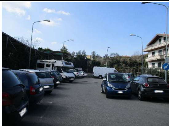
Foto 3: Piazzale con fessurazioni
