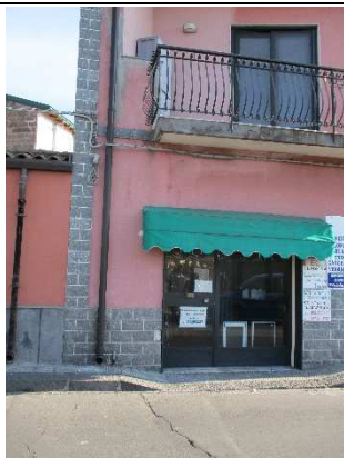
Foto 3: Sarciture nella parte alta dell'edificio di foto 1
