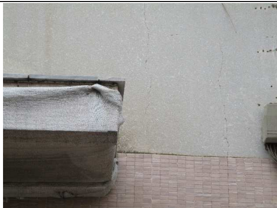
Foto 3: Piccole lesioni su edificio, estese sul prospetto
