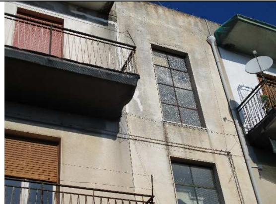
Foto 2: Dettaglio foto 1 su lesioni sarcite
