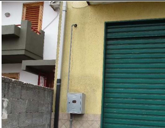
Foto 1: Piccola lesione su lato sinistro edificio
