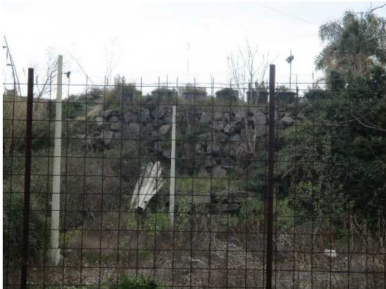
Foto 1: Scarpata in corrispondenza del Kartodromo
