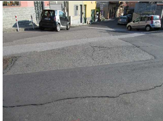
Foto 2: Via Macello angolo via Buscemi
