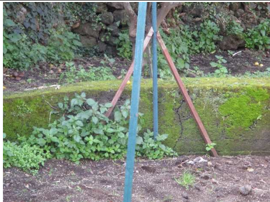
Foto 1: Danni su manufatti
