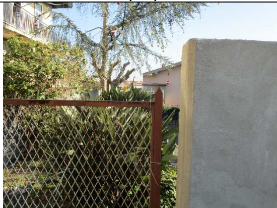
Foto 3: Edificio lesionato (al centro in secondo piano)
