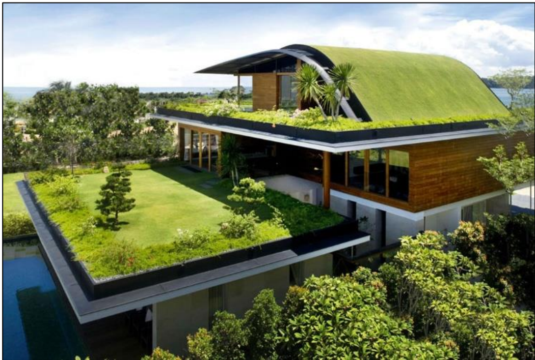
Fig. 18 - Realizzazione di tetti verdi.
